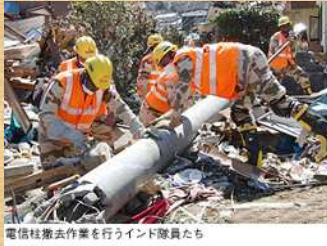
電信柱撤去作業を行うインド隊員たち
