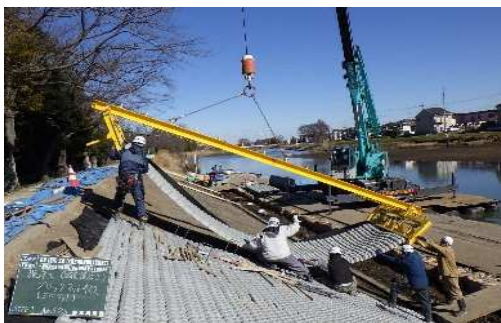
護岸工事の施工状況 (治水対策)
