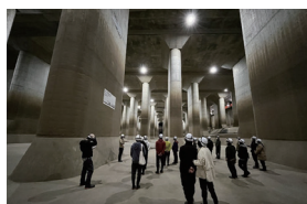
首都圏外郭放水路の見学会の様子
