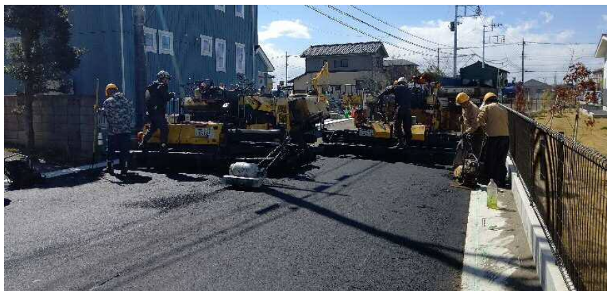
再生骨材を用いたアスファルト舗装工事
