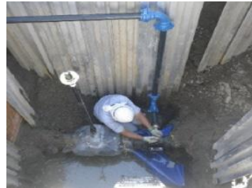
<給水工事>安心安全な水をお届けします
