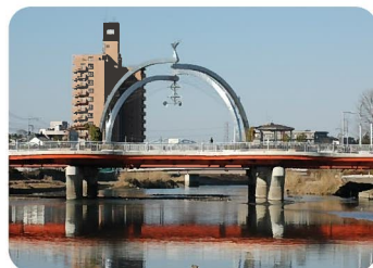
古利根公園橋
