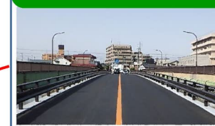
橋りょう 長寿命化修繕事業
