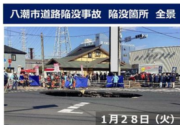
図 7 県下水道管の破損に起因する八潮市内道路陥没事故の状況
