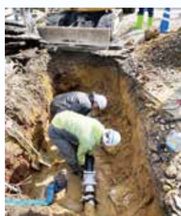
水道管復旧の様子
