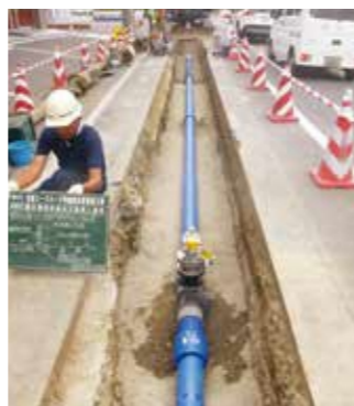
市内水道管工事の様子
