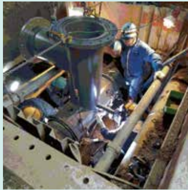
新しい水道管に更新している工事の様子
