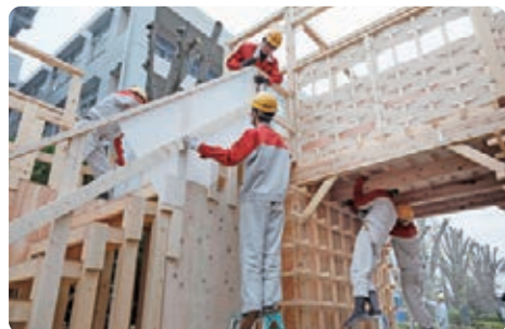
文化祭終了後、仲間と1つのことを成し遂げた達成感を抱きながら、アーチの解体作業に取りかかる生徒たち。
