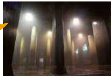
首都圏外郭放水路
