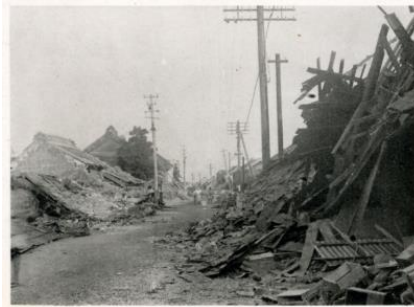
1-9 関東大地震の被害状況(粕壁上町)(出典:かすかベデジタル写真館)
