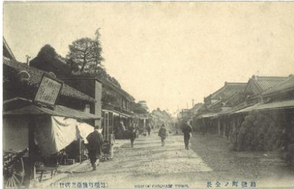
1-45 粕壁町の全景(明治40年頃) (出典:かすかベデジタル写真館)
