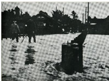
1-10 カスリーン台風の被害状況(春日部町・新町橋)(出典:かすかベデジタル写真館)
