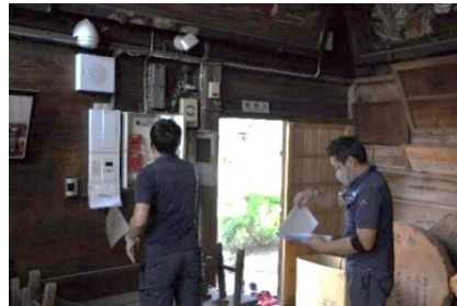
8-11 防災設備保守点検
