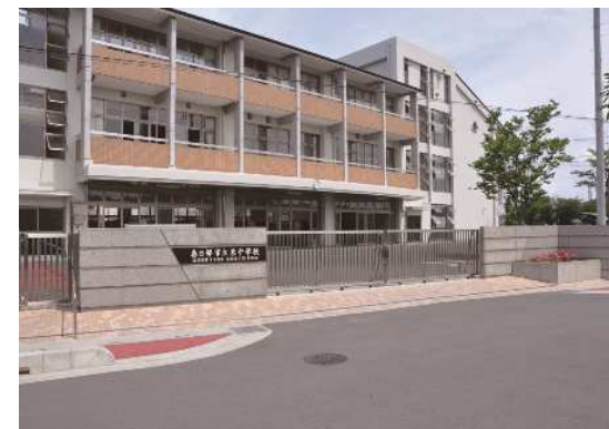
春日部市立東中学校 新校舎（12月竣工）
