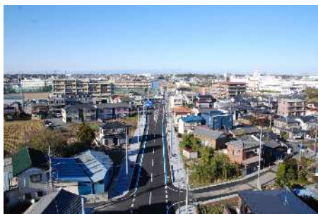
国道16号接続部付近の中央通り線
