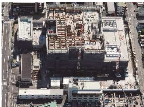
新市立病院工事施工写真
