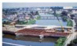
▲建設中の古利根公園橋 (下流に春日橋、埼玉橋を望む)
