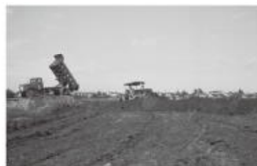
造成中の春日部駅西口の様子 写真右後方に春日部駅を望む。
