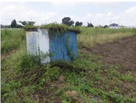
写真 41 井戸 (ポンプ小屋)
