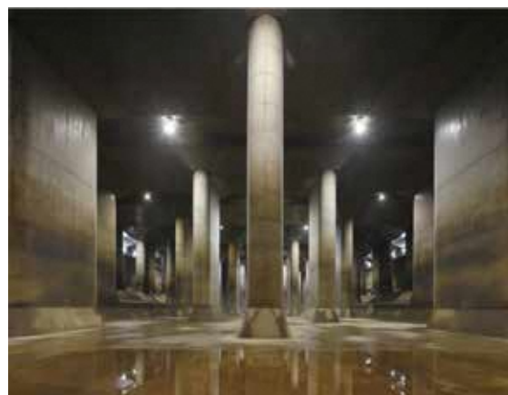
写真 48 首都圏外郭放水路 (国土交通省提供)
