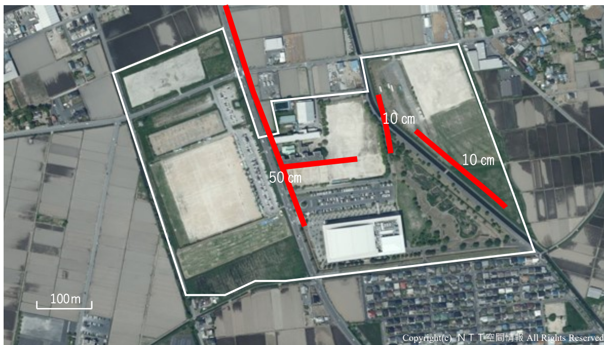
図 2-29 冠水箇所・冠水深さ
