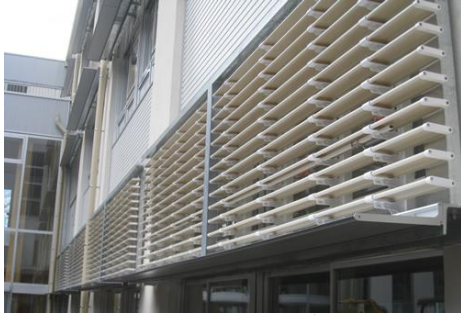
写真9. ルーバー (福井県若狭町立三方中学校)
