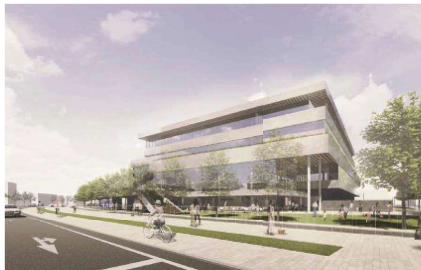
市役所通り・陸橋通り交差点より見たイメージ
