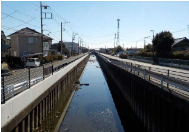
谷中橋付近から見た、工が進んでいる準用河川安之堀川
