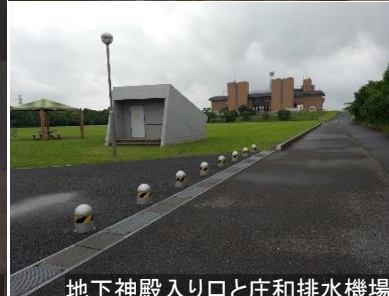
地下神殿入り口と庄和排水機場
